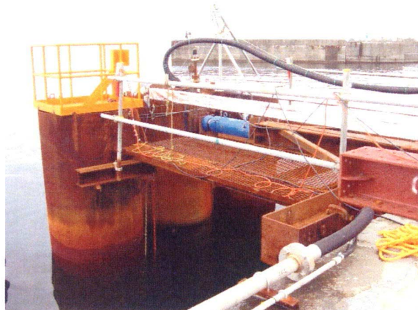
写真-6 水平载荷試験の状況
