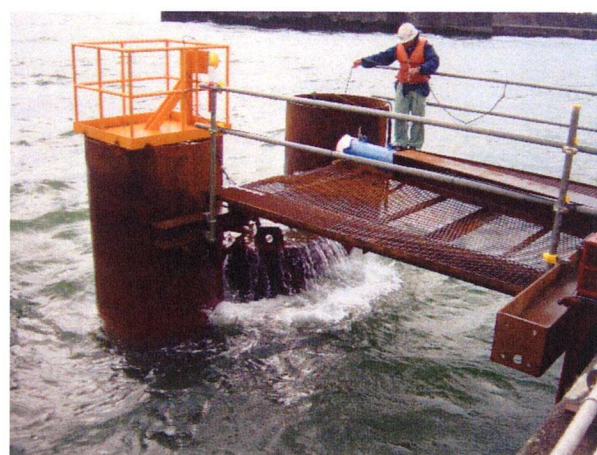
写真-5 浮上試験の状況（浮上中）
