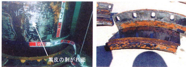
写真-9 1年経過後の磨耗・腐食状況 (左：ラップ部，右：スタビライザー)
