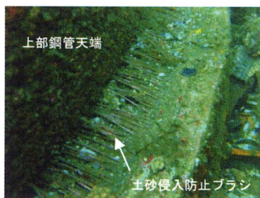
写真-10 土砂侵入防止ブラシの状況（1年経過後）
