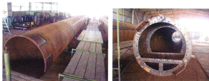
写真-2 上部鋼管の製作状況（左：下端，右：上端）
