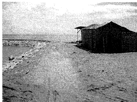
写真-6 養浜砂浜上での違法建築物の設置
