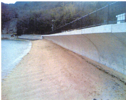
写真-3 フレア型護岸設置から約1年後 (2006年3月撮影)
