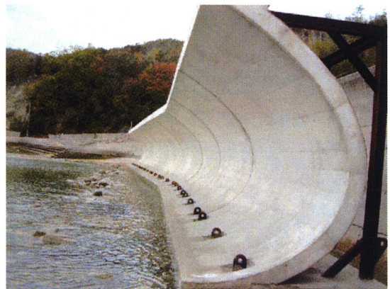
写真-2 フレア型護岸設置直後の状況 (2004年12月撮影)
