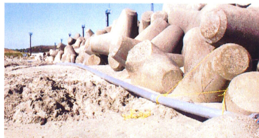
写真-3 排砂管敷設状況
