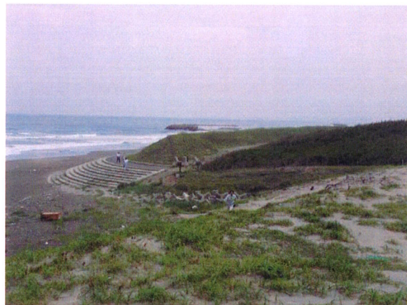
図-5 23号HLの北約420mにおいて撮影した保安林防護のための土堤と護岸の北端部
