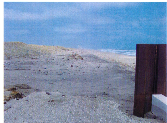
図-16 護岸の端部状況
