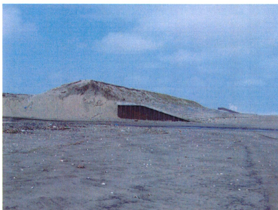
図-14 保安林の新しい防護施設を海側から撮影
