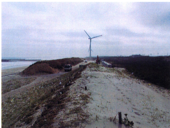
図-13 図-12と同じ場所から南東方向を望む
