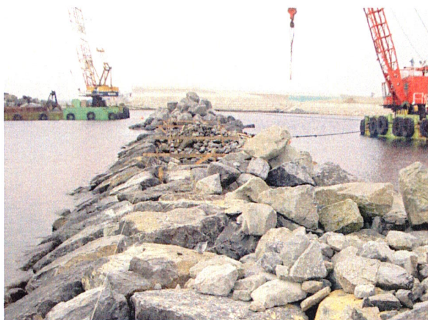
写真-4 施工中の状況
