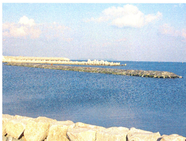
写真-6 完成写真（傾斜堤全体）
