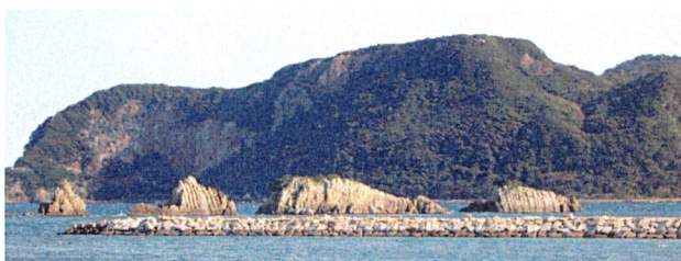
写真-1 自然石で被覆された離岸堤の一例
