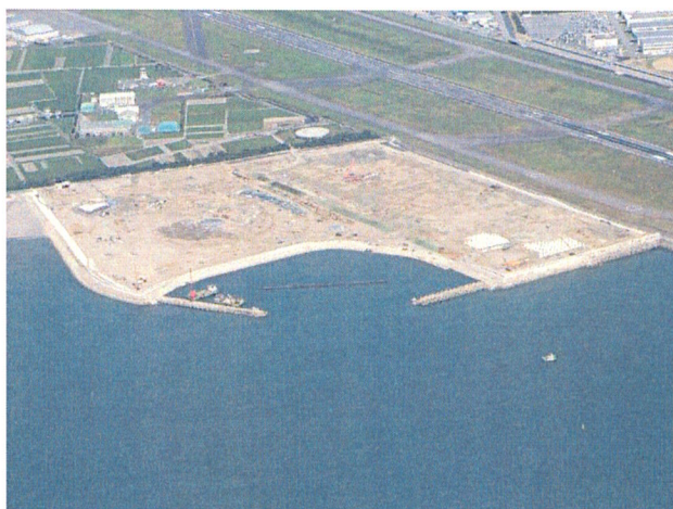
写真-5 傾斜堤完成時の航空写真 (徳島県ホームページより)
