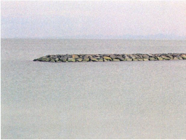
写真-7 完成写真（堤頭部拡大）
