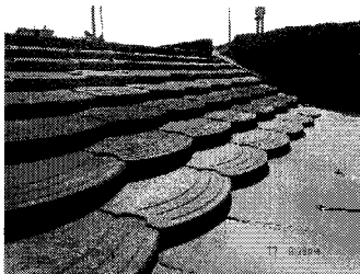
写真-5.1 千葉県向浜海岸階段式護岸
