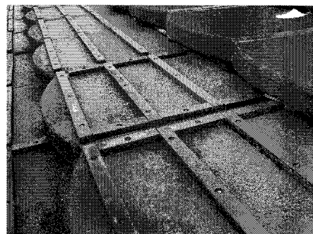
写真-3.1 滑り止めゴムバー設置状況
