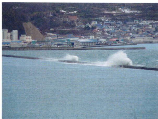
写真-8 エネルギーを放散して北防波堤を駛する越波
