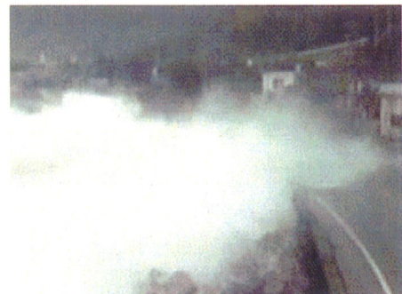
写真-1 越波状況
