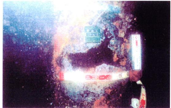
図-3 鋼管杭の腐食穴の例
