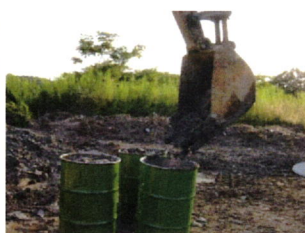
写真-5 重機による搬送
