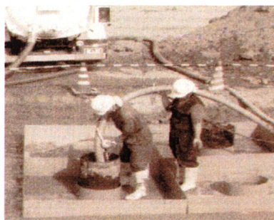
写真-2 真空ポンプ工法
