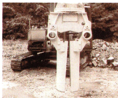
写真-1 円柱半割バケット工法
