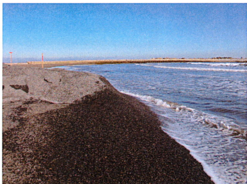
写真-2 南側隅角部での波の浸透状況
