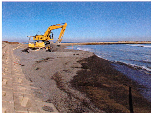
写真-1 砂礫の投入状況
