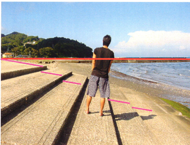
写真-1 階段型緩傾斜護岸の踏み面の勾配
