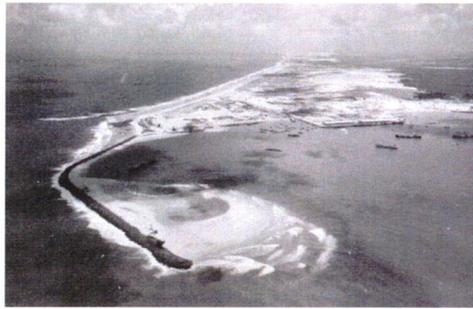
写真-3 港内堆砂状況 (防砂堤建設前)
