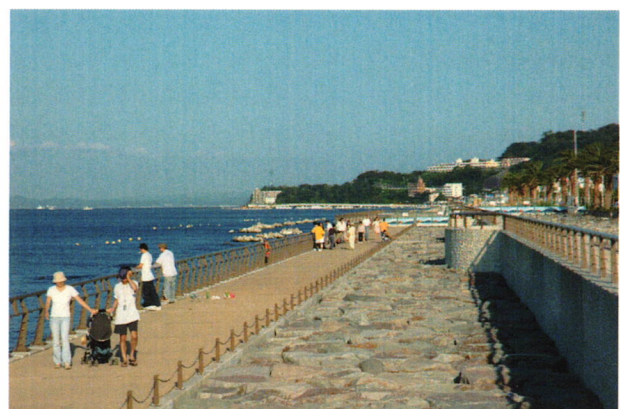
写真-1 横須賀港馬堀海岸地区護岸
