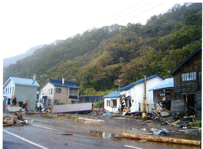
写真-1 越波による家屋被害状況
