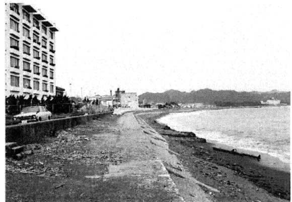
写真-4 高波浪後の海岸状況
