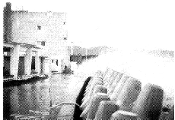
写真-3 護岸背後から北向きに越波状況を撮影
