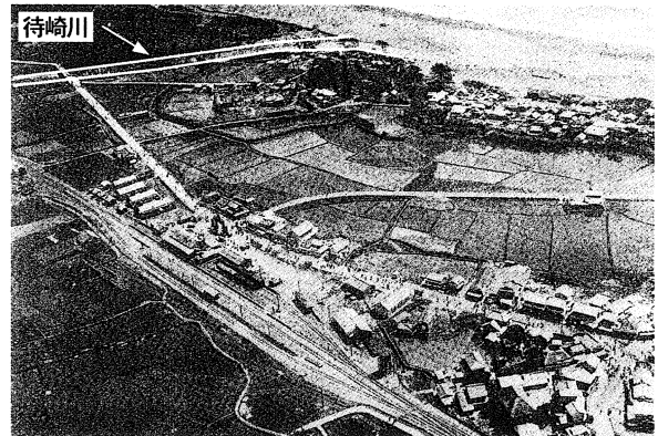
写真-1 待崎川（上部）と鴨川駅周辺（下部）を撮影した斜め空中写真（1929年4月15日撮影）
