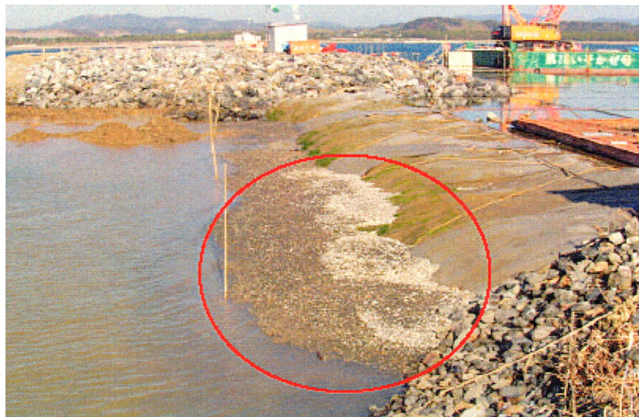
写真-1 腹付工（再生骨材等 40mm 以下）の適用事例（志布志港）
