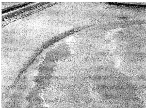
写真-3 離岸堤近傍の沿岸漂砂下手側海浜状況
