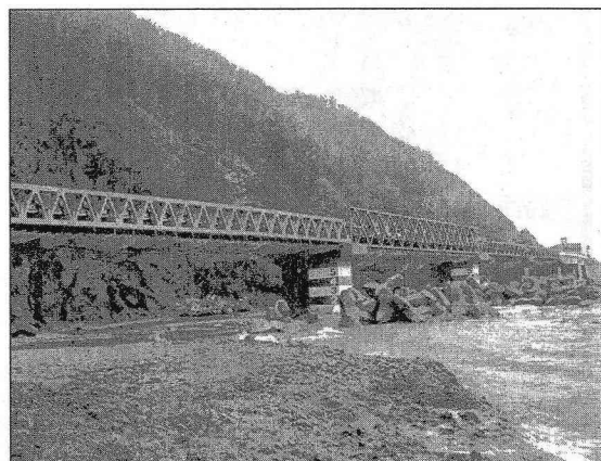
写真-5 復旧した大森大橋
