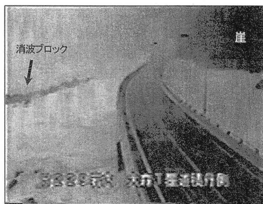
写真-2 落橋前の大森大橋の映像
