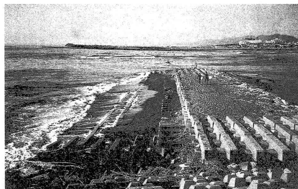
写真-3 写真-2と同じ横堤 (11月21日撮影)
