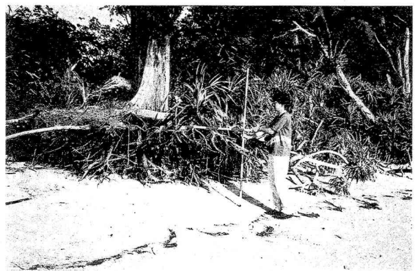
写真-3 フックAの付け根付近に形成された高さ1.1mの浜崖(2001年9月9日撮影)
