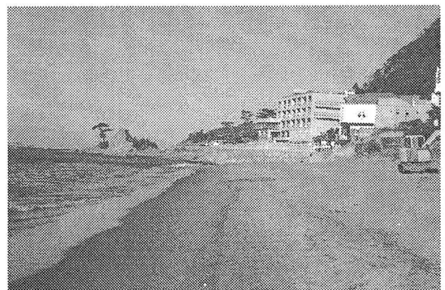
写真-4 前田川河口導流堤から北側を望む(2004年12月2日)
