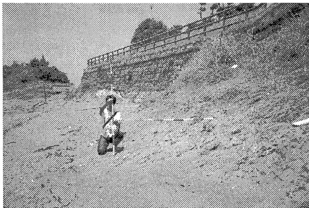
写真-5 立石背後の護岸と前浜の状況(2004年6月4日)
