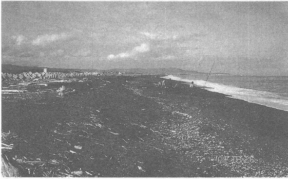
写真-5 コムケ湖口の導流堤上から西向きに撮影。導流堤の西側隣接区域には大量の砂が堆積し広い前浜が広がる
