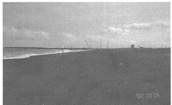
写真-8 湧別漁港防波堤西側に砂が堆積して形成された広い前浜
