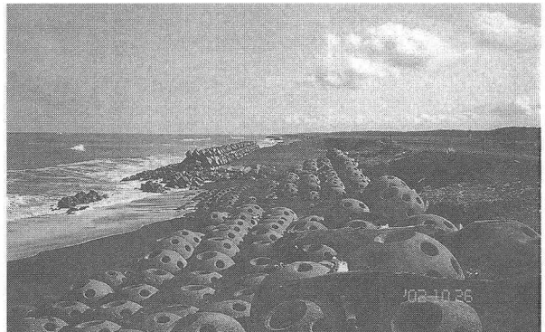
写真-9 湧別漁港東側隣接域での侵食対策
