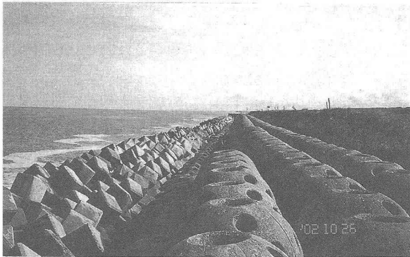
写真-12 3列のタートルブロックと6脚ブロックの乱積みで防護された海岸
