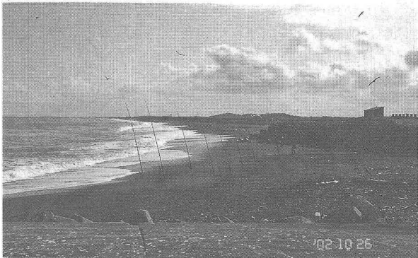
写真-6 コムケ湖口の導流堤東側直近での侵食状況
