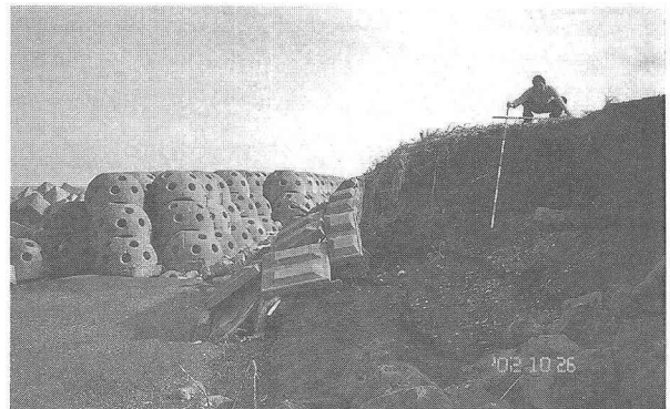
写真-10 既設護岸が崩壊し、裏側が削り取られて形成された約1.8mの浜崖
