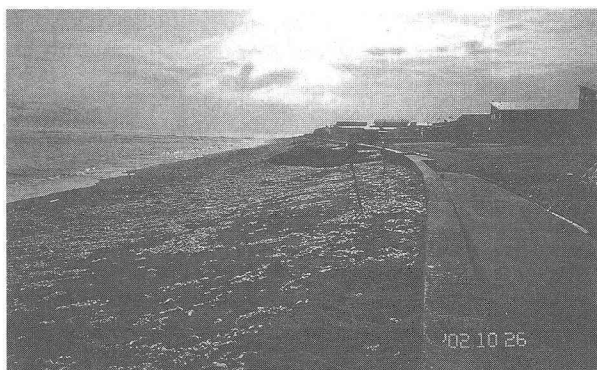
写真-1 紋別港防波堤北西側での堆砂状況
