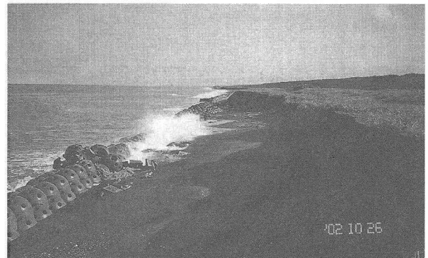
写真-15 消波堤の東側端部の状況
