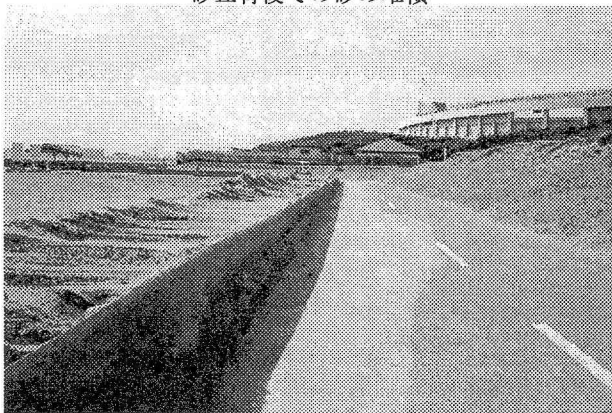
写真-3 フェンス前面・背後の堆砂を除去した後 の状況
