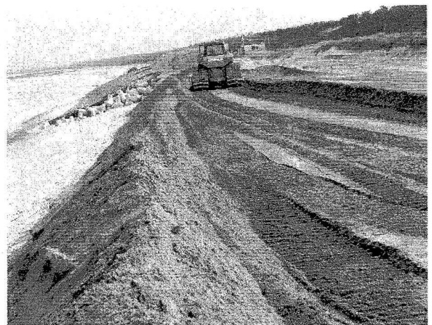
写真-1 河口浚渫土砂を用いた養浜
