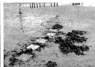
写真-3 パスタ ロックの 埋設状況
