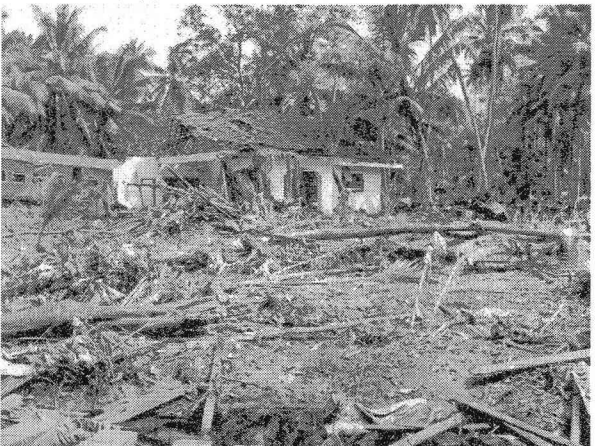
写真—3 スリランカ、カハワ地区での被災状況
