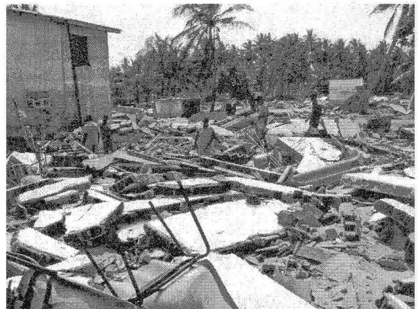
写真—4 破壊された住宅（スリランカ）
