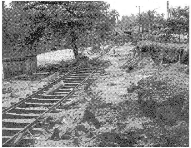
写真—9 鉄道基礎の侵食（スリランカ）
