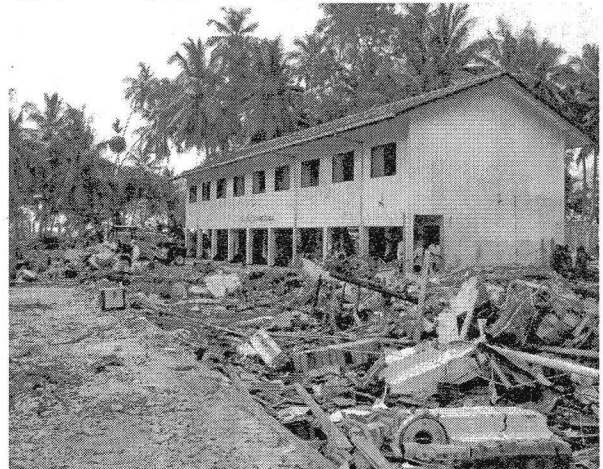
写真—5 残された建物（高校の校舎）（スリランカ）
