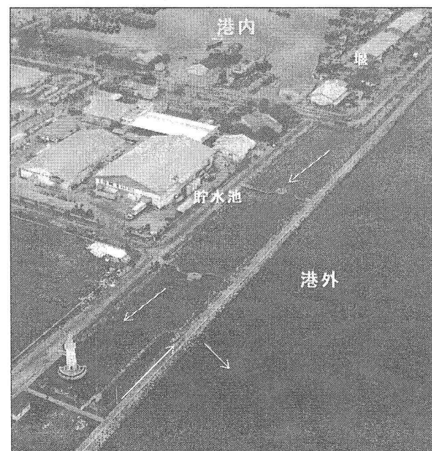
写真-8 港内海水交換システム全景写真
