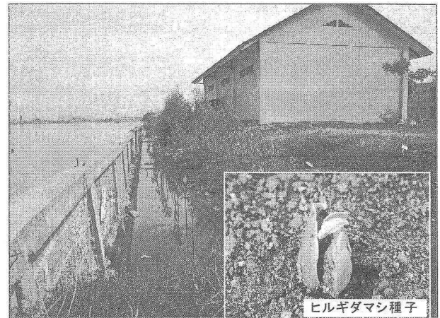
写真-4 マングローブ植栽直後の西護岸 (2000年12月)
