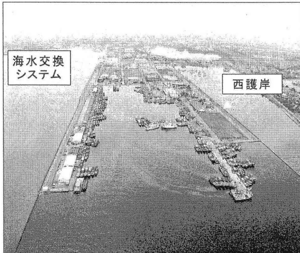
写真-1 ジャカルタ漁港全体写真
