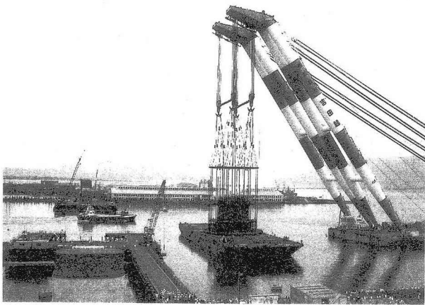
写真-3 大組鉄筋・鉄骨の据付状況
