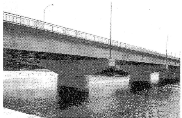
写真-1 波之上橋 (工事完了後) 手前よりP8、P7橋脚
