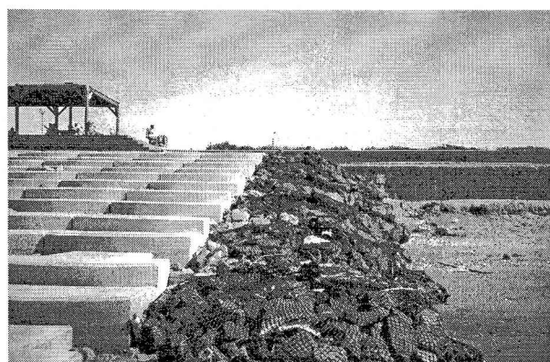
写真-6 北側海浜の緩傾斜護岸の南端部の状況
