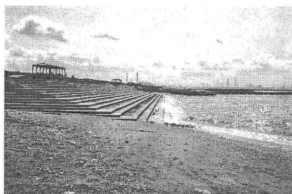
写真-3 北側海浜の緩傾斜護岸を北側から望む
