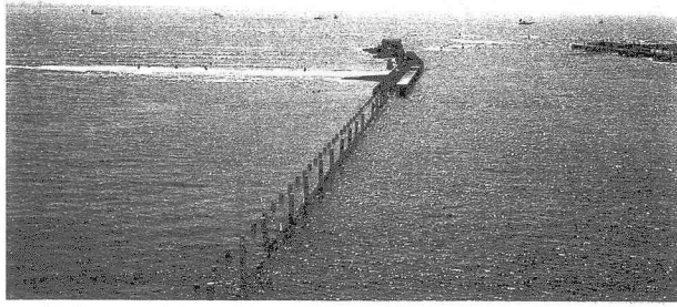
写真-5 河口テラスと導流堤との接点付近の状況
