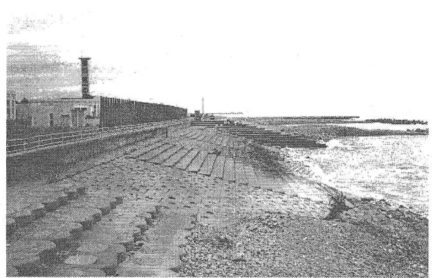
写真-6 3号離岸堤背後から2号離岸堤を望む
