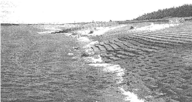
写真-9 3号離岸堤の北側状況
