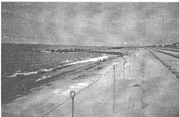
写真-1 1, 2号離岸堤間から2号離岸堤を望む
