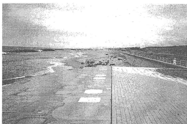
写真-11 環境整備区間の北端状況
