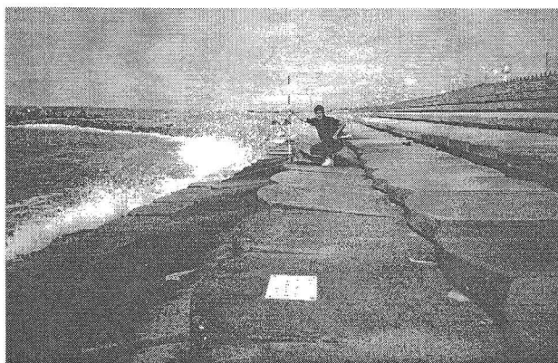
写真-3 2号離岸堤近郊の緩傾斜護岸
