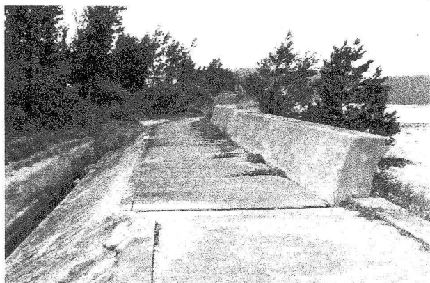
写真-2 コンクリート傾斜護岸水叩き (屋嘉田海岸)
