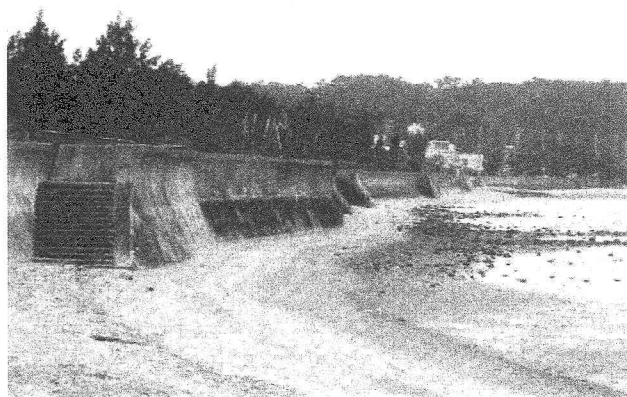
写真-3 連続するコンクリート傾斜護岸 (屋嘉田海岸)
