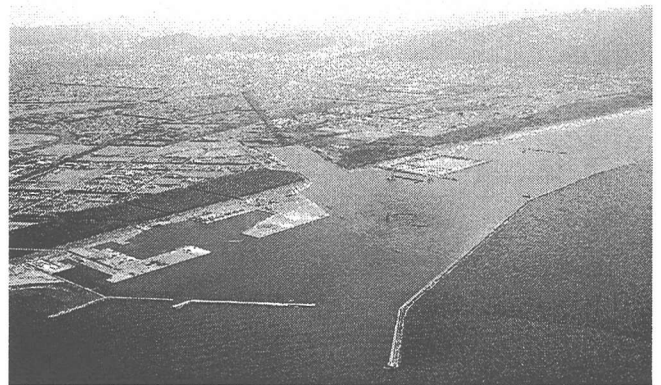
図-2 石狩湾新港全景
