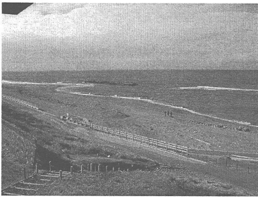
写真-1 離岸堤背後の舌状砂州(平成14年11月)
