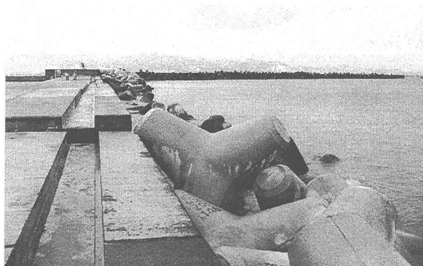
写真-2 基部側状況
