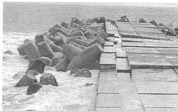
写真-3 先端側状況
