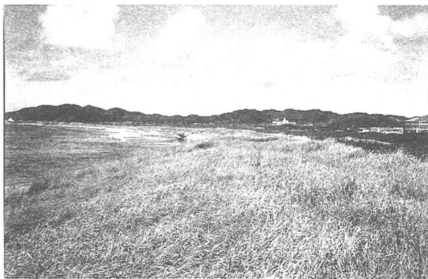
写真-2 土堤天端の海側端部から西側を望む (2002年9月17日)
