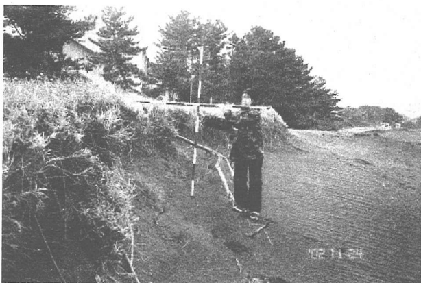
写真-4 自然砂丘中間地点の浜崖状況
