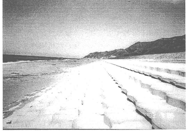
写真-6 野積海岸における緩傾斜護岸
