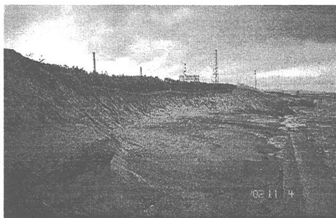
写真-14 護岸の倒壊と背後地の侵食状況
