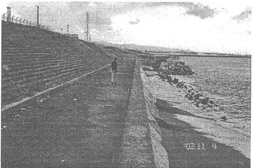
写真-11 直立護岸と汀線との接点付近の状況
