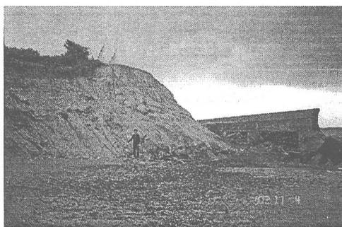
写真-16 護岸背後の著しく高い浜崖
