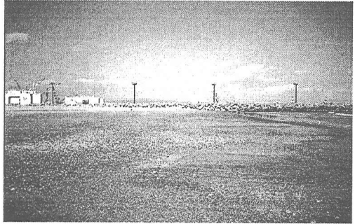
写真-9 作業基地の南防波堤の隣接域を遠望する
