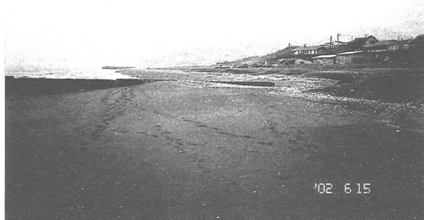
写真-4 写真-1に示す突堤の北側にある突堤Bを南側から撮影
