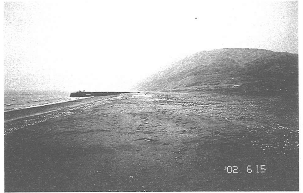
写真-7 染川河口導流堤の南側での堆積状況
