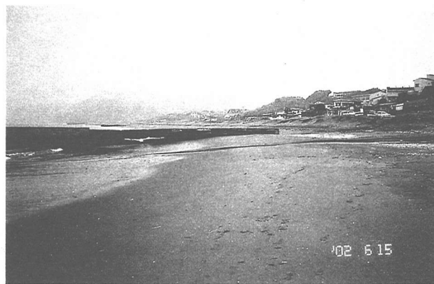
写真-1 突堤を南側から撮影
