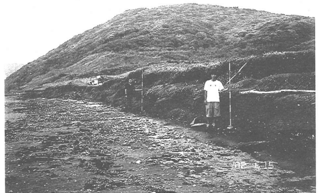
写真-9 染川河口右岸側での浜崖侵食状況
