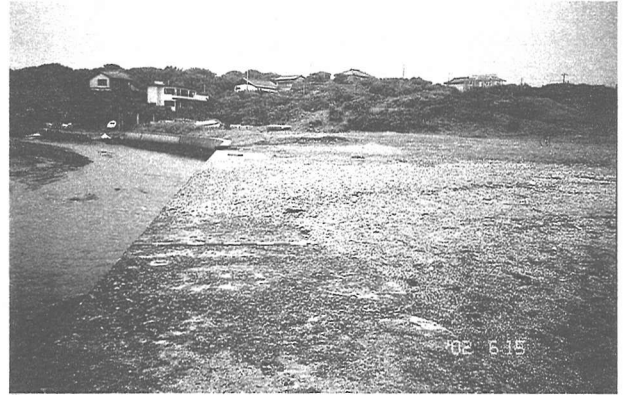
写真-8 左岸導流堤上から河口の上流方向を望む
