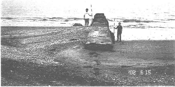
写真-5 突堤基部から先端方向を望む
