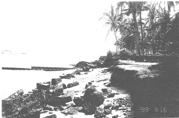
写真-13 図-2のD付近における海岸侵食状況 (西向きに撮影) (1999年9月16日)
