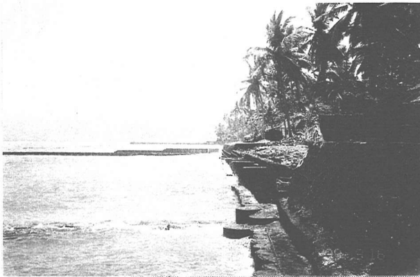
写真-8 海岸線に沿って延びる海岸護岸 (1999年9月16日)
