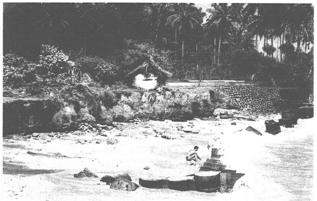
写真-11 海岸線の湾入部での海岸侵食状況(図-2 のCで1999年9月16日撮影)
