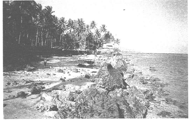
写真-14 破壊された海岸護岸の残骸 (図-2のD付近で2002年8月9日撮影)
