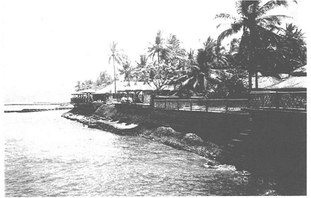
写真-6 護岸で守られた海岸線とその背後の施設 (1999年9月16日)
