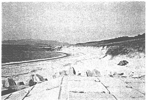
写真-4 護岸端部での浜崖形成状況（図-2 (d) のCで撮影）
