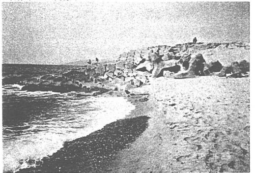
写真-7 護岸端部の状況
