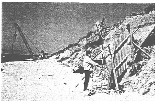
写真-7 矢板工事箇所の手側の海岸状況
