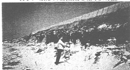
写真-10 浜崖の南側で北向きに撮影
