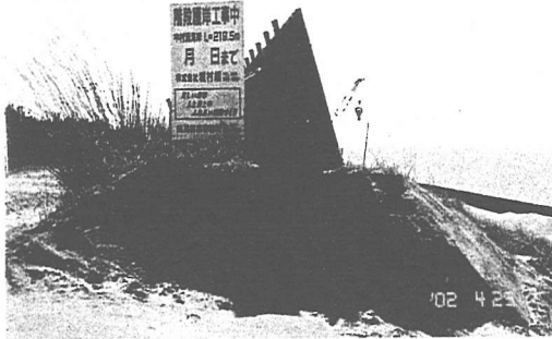
写真-3 護岸工事中の看板
