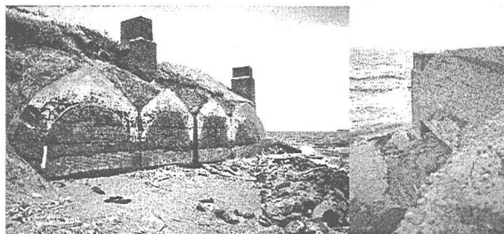
写真-1 W1地区における現在の景観の状況 機関舎(左)及び電灯井(右)
