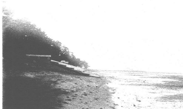
写真-9 大新田海岸において建設されつつあった 階段護岸 (1985年4月)
