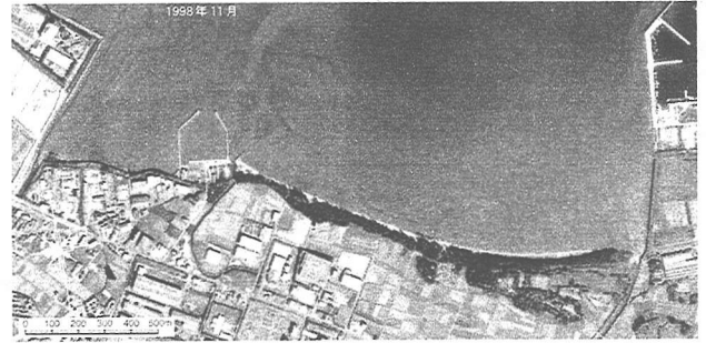
写真-2 大新田海岸周辺の空中写真(1998年)
