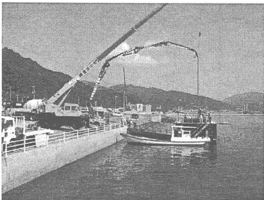
写真-2 変形追随遮水材料の打設状況
